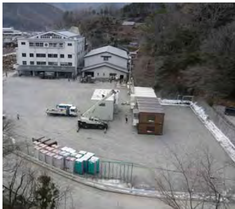
大槌小学校校庭にプレハブ庁舎建設中の様子
