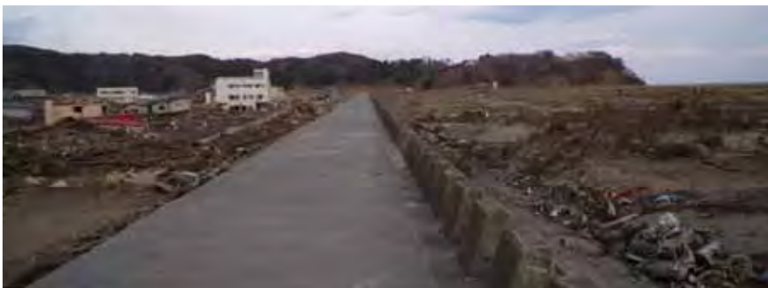
海岸から二重目の防潮堤 (右側が海側)
