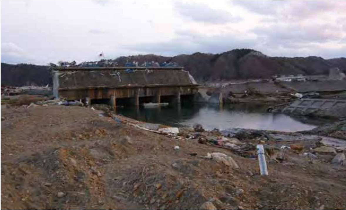
宮古市田老地区（4月2日）破壊された防潮堤
