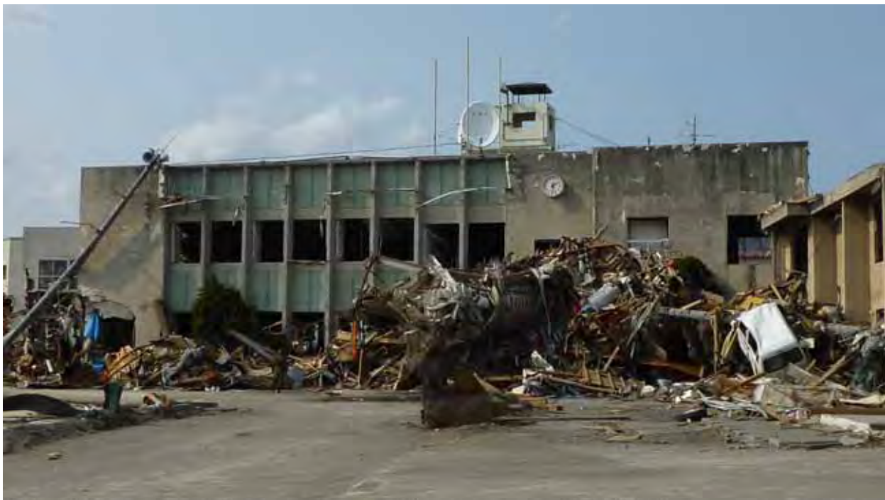
被災した大槌町役場（4月2日）2階天井まで津波は到達
