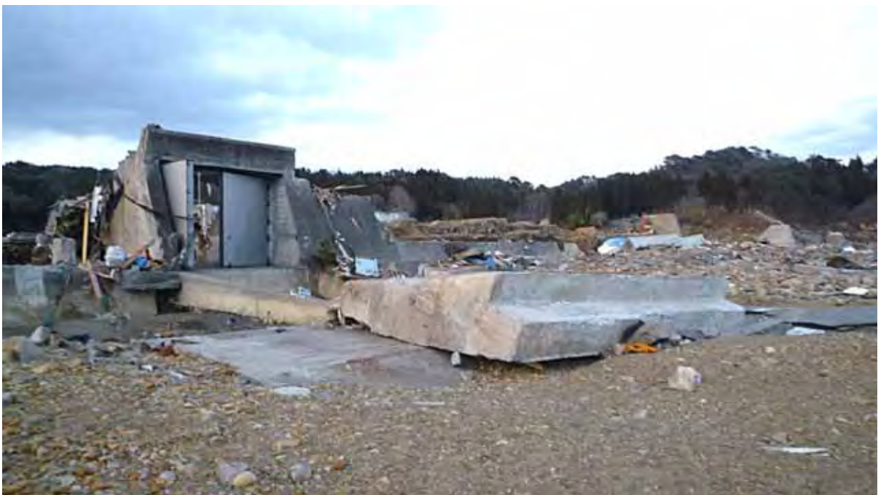
宮古市田老地区（4月2日）破壊された防潮堤
