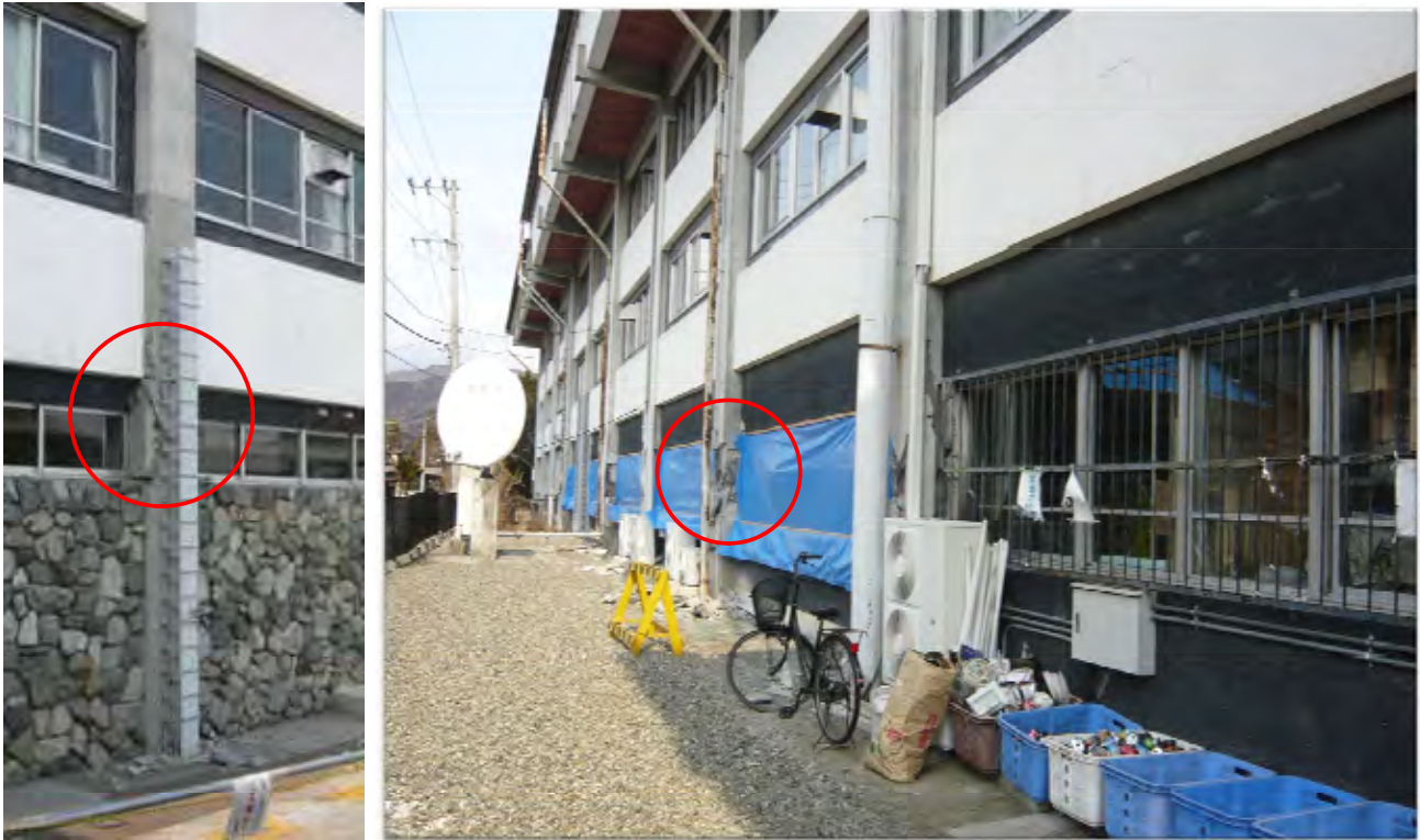
遠野市本庁舎中央館 全壊
