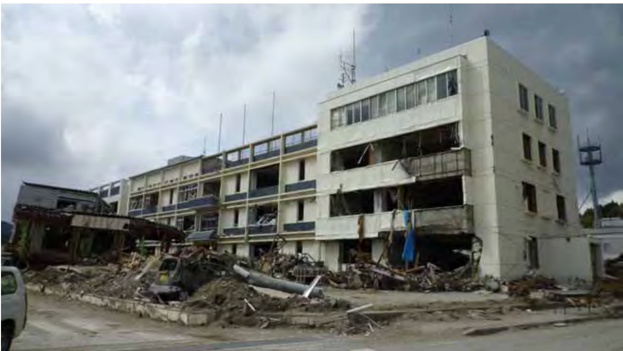
被災した陸前高田市役所（4月4日） 3階天井まで津波は到達
