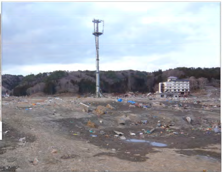
宮古市田老地区 （4月2日）RC造だけ残存
