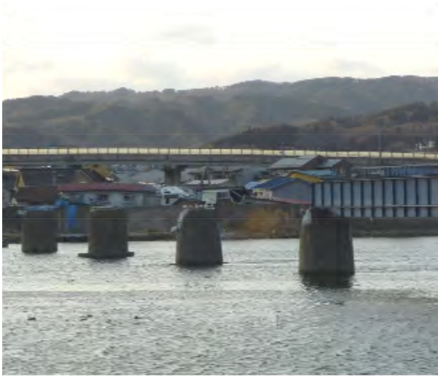
閉伊川河口部 津波でJR山田線橋脚が流される
